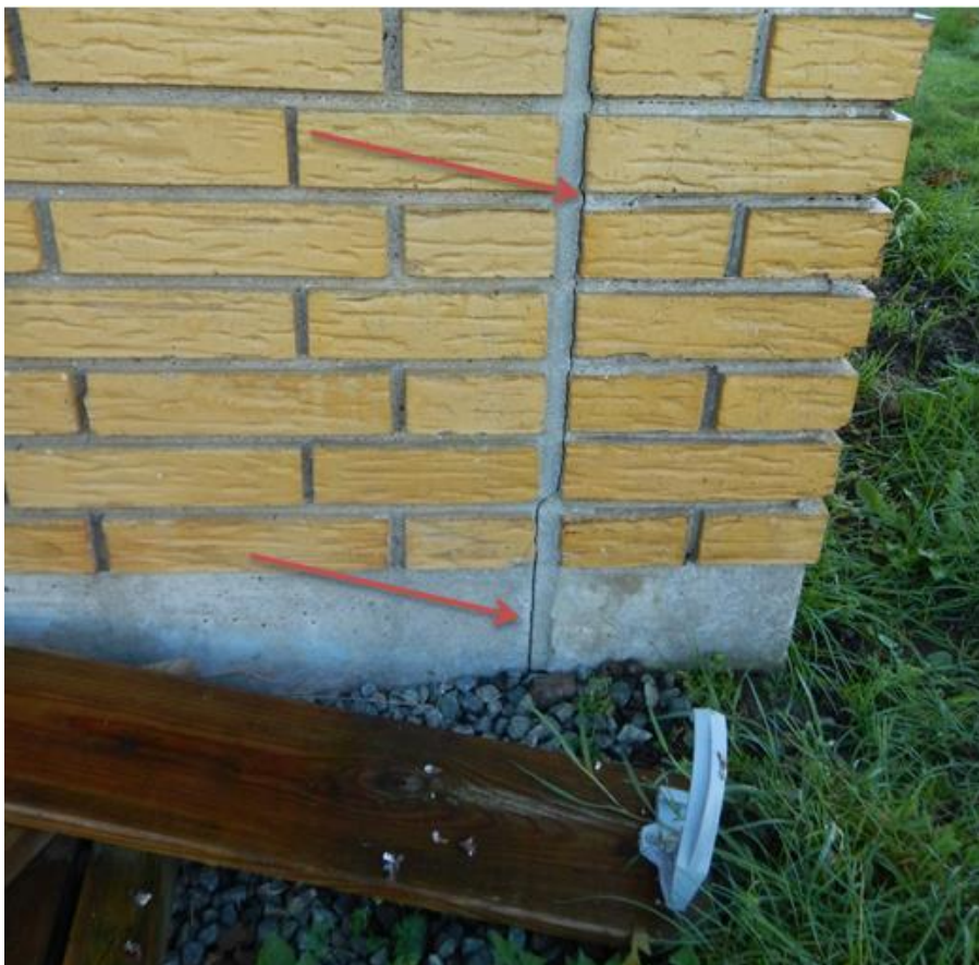
Foto nr. 01. Facade mod nord: Sætningsrevne mellem elementer.
