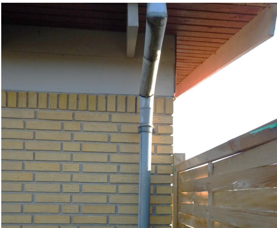
Foto nr. 02. Facade mod vest: Utæt taggedløb
